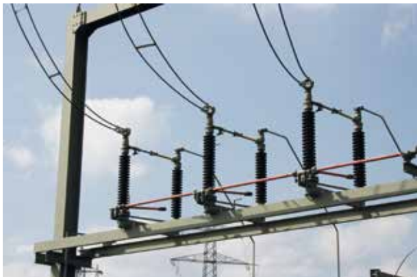
Bild 2: Drehtrenner sind die häufigste Bauform
