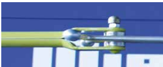
Bild 3: Versilberte Kupferkontaktteile am Drehtrenner, idealer Kontaktbereich am Drehtrenner
