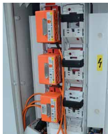
Bild 4: Die Powermodule sind kompatibel mit NH02 und NH03 Sicherungshaltern. Sie haben die derzeit kleinste Bauform auf dem Markt.
