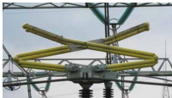
Bild 6: Ein typischer Scherentrenner
