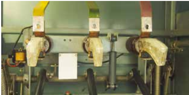
Bild 2: Verschiedene Werkstoffe an Kontaktstellen [5]
