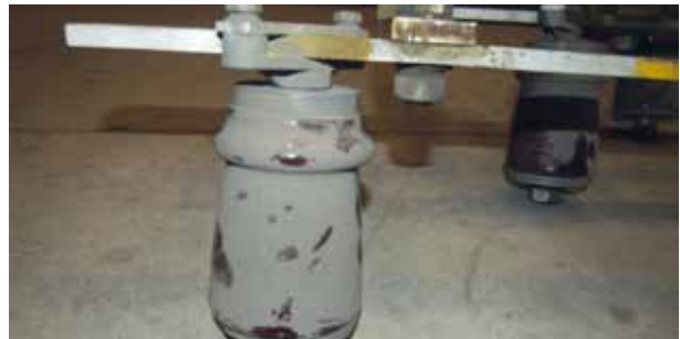
Bild 3: Verschmutzte Schaltanlage [5]
